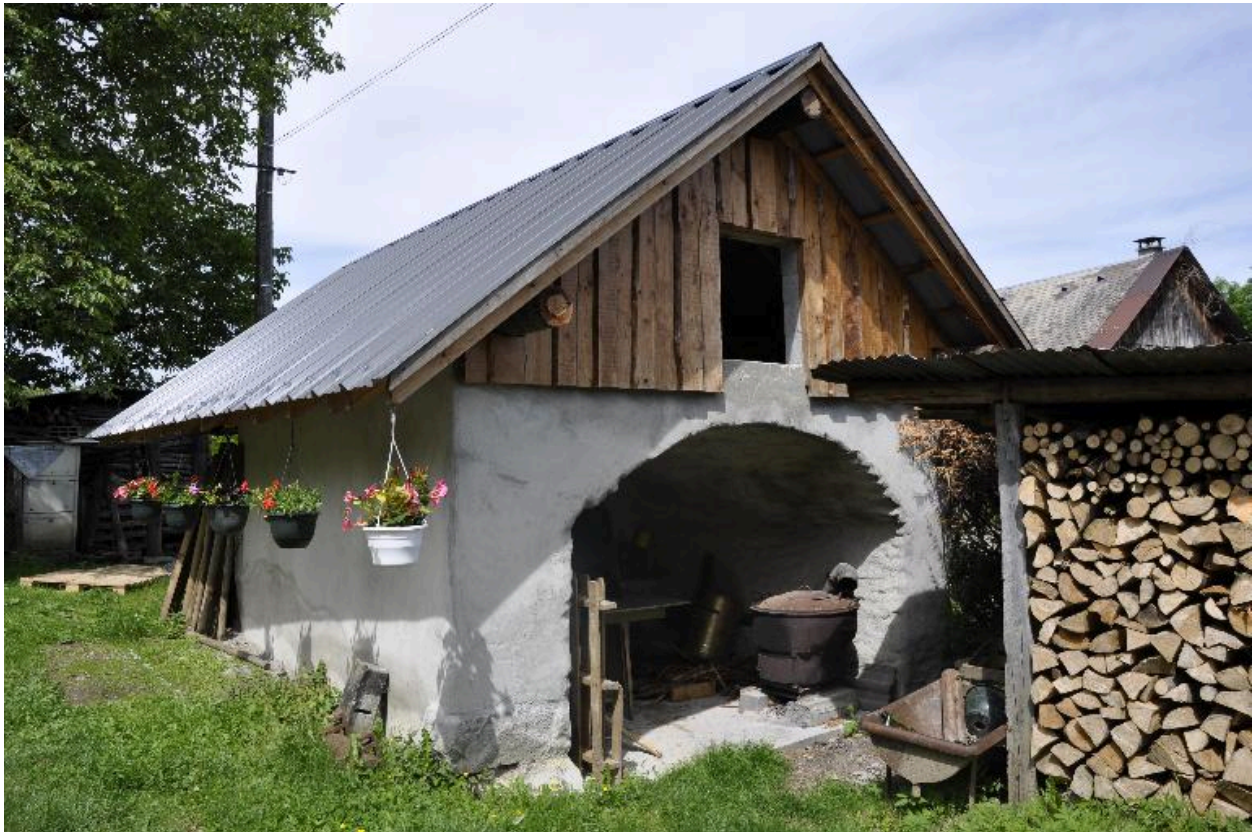
Vue du four à pain.
