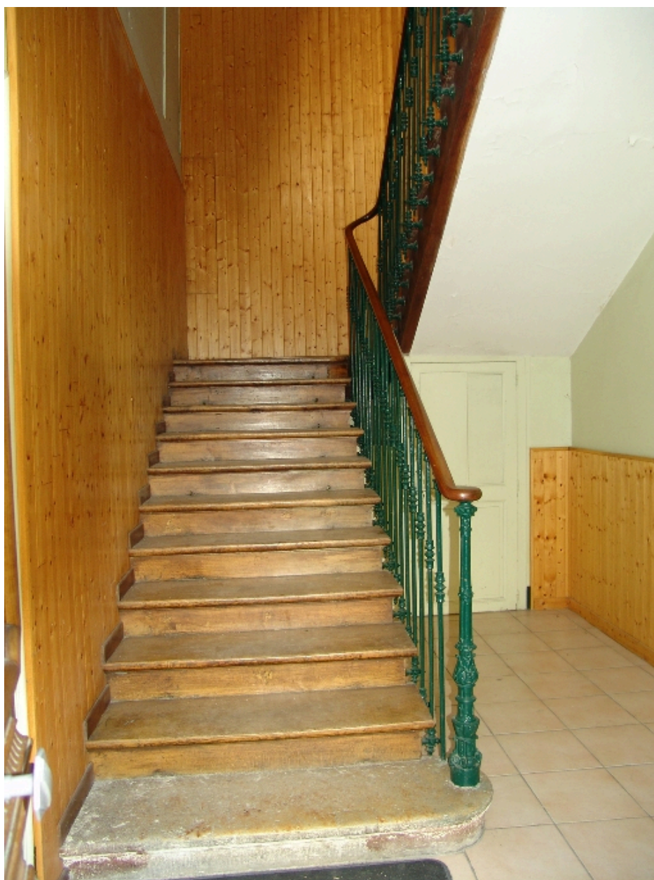
Départ de l'escalier intérieur
