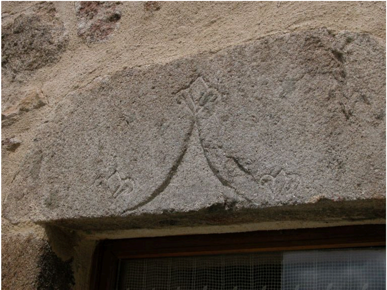
Détail de linteau avec accolade gravée
