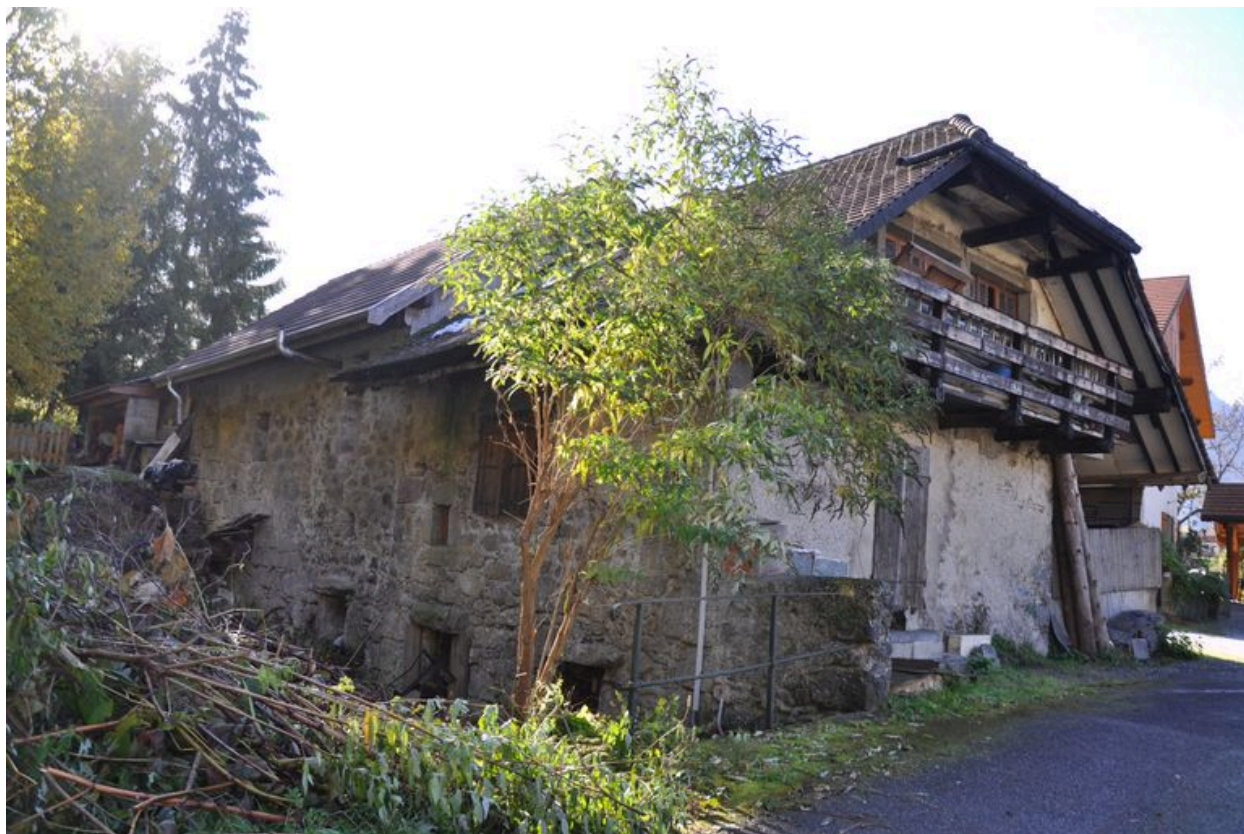
Elévation nord-est du bâtiment du moulin
