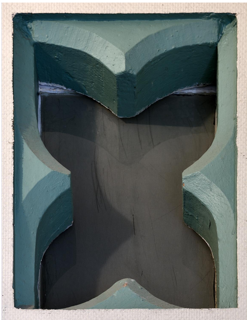
Fenêtre de second jour dans la cage d'escalier
