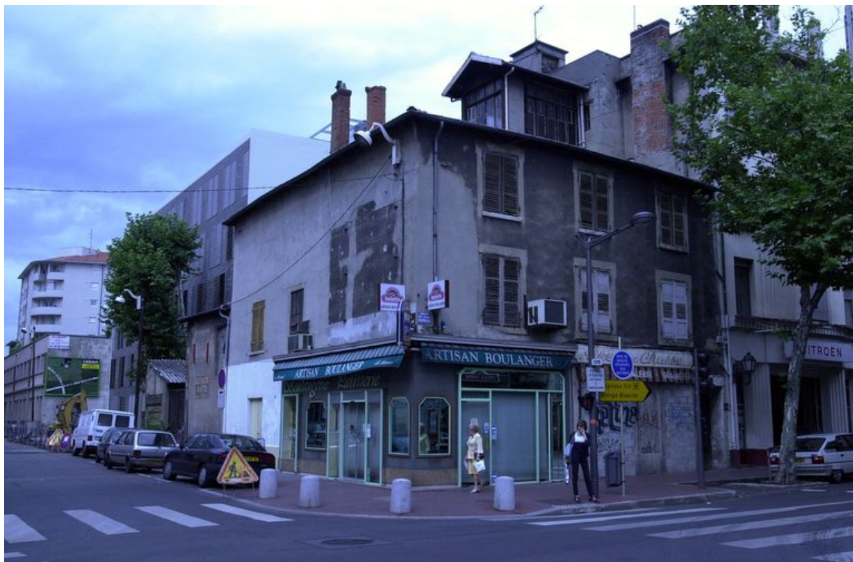
Vue générale des façades sur rue
