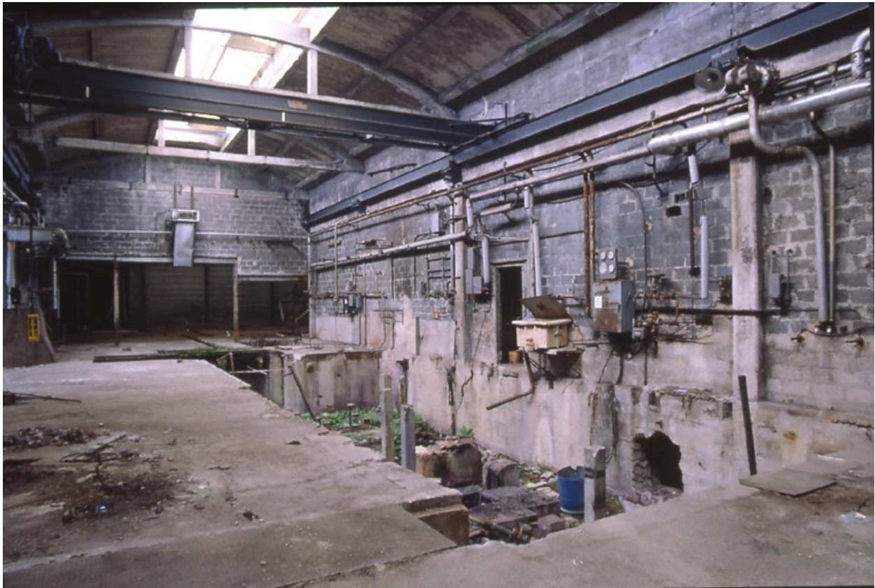
Fosse d'emplacement de machines
