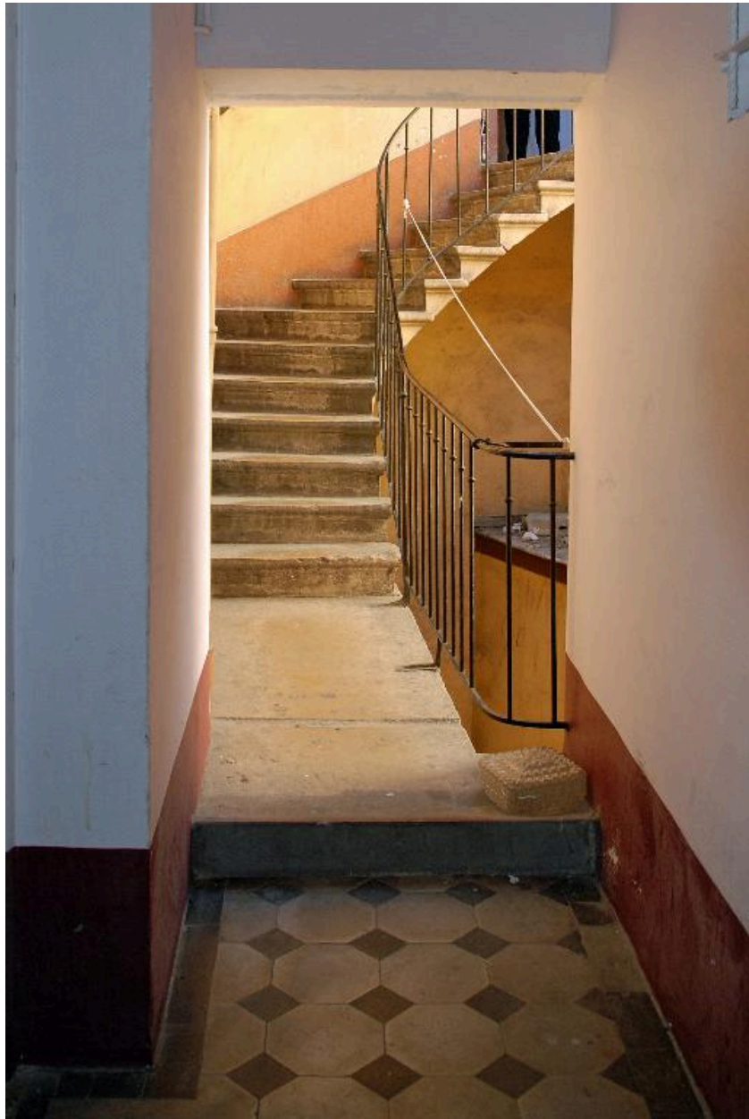
34 rue Montesquieu : vue du troisième palier donnant sur la coursière
