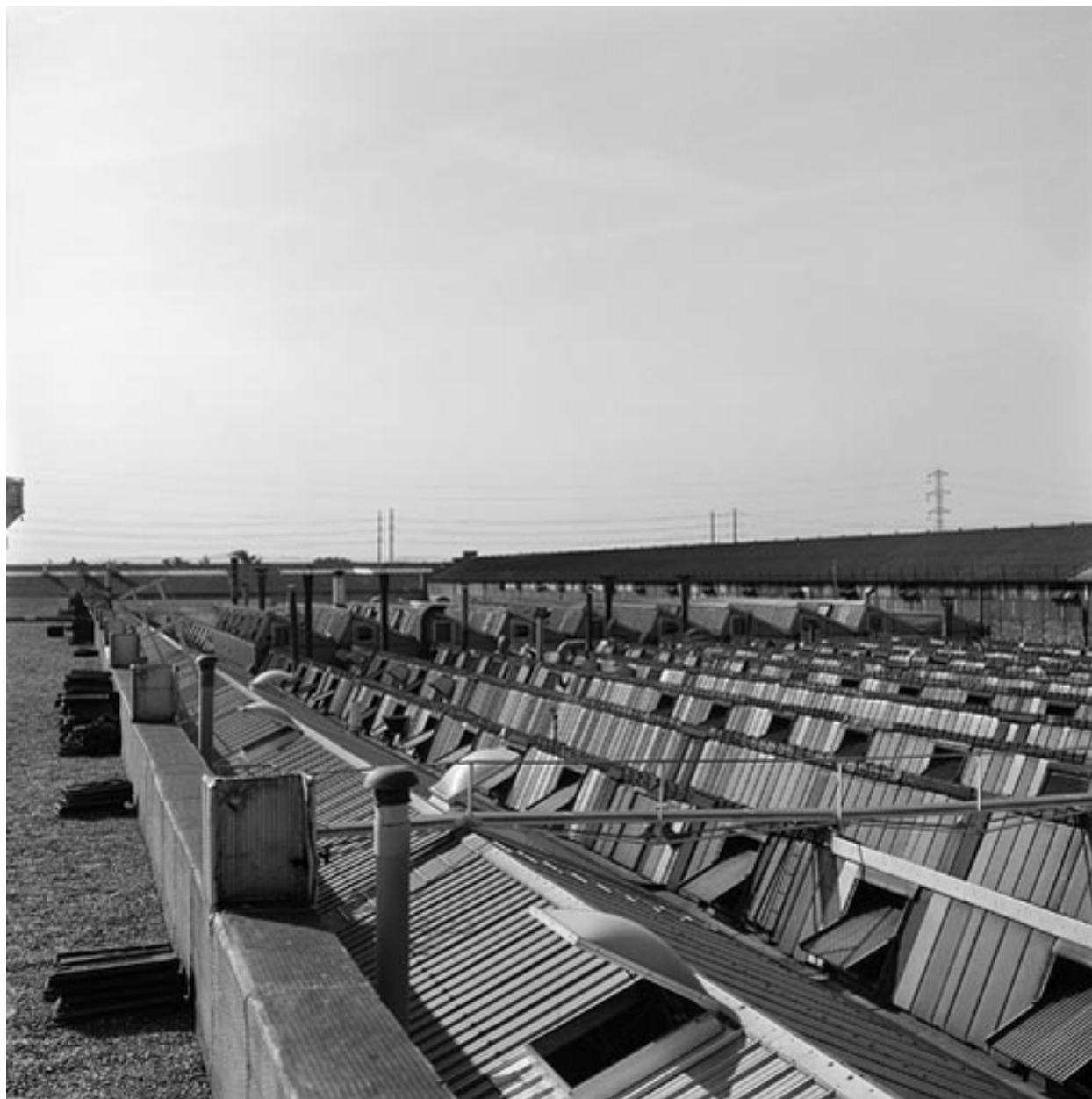
Toit sheds des ateliers de l'usine moteur
