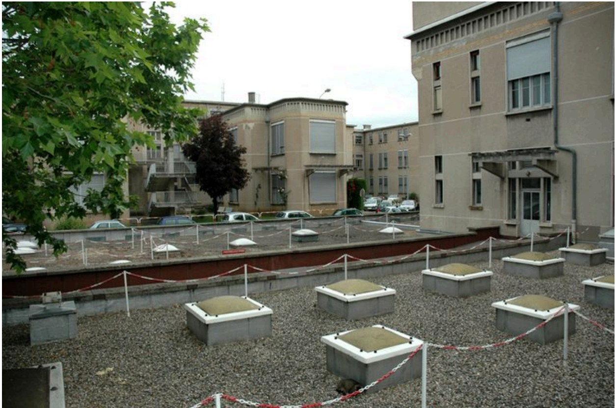
Le pavillon H. Vue depuis le sud-ouest. Au 1er plan, l'occupation de la cour anglaise ouest du pavillon N
