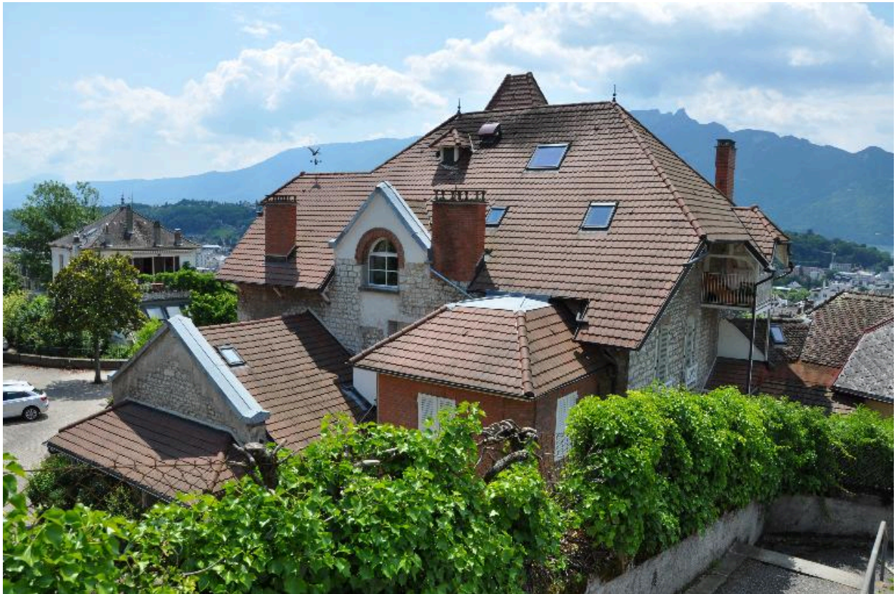
Vue générale depuis le nord-est, les toitures
