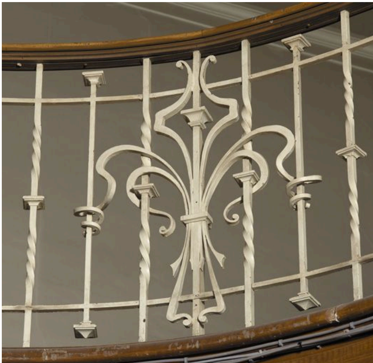
La grande salle, ancienne patinoire : détail du garde-corps de la galerie
