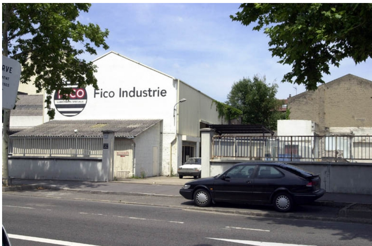
Vue générale entrée des marchandises
