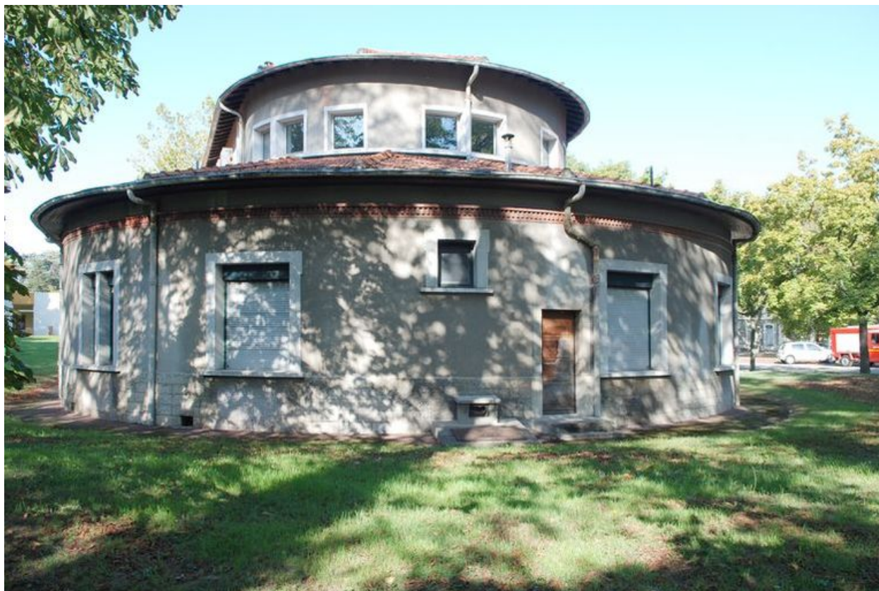
Bâtiment 207 depuis l'est
