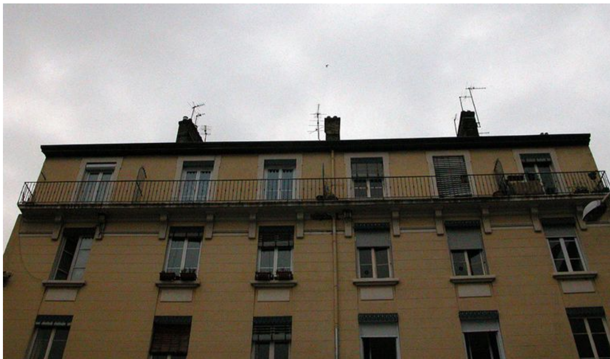
Vue du balcon filant au dernier étage
