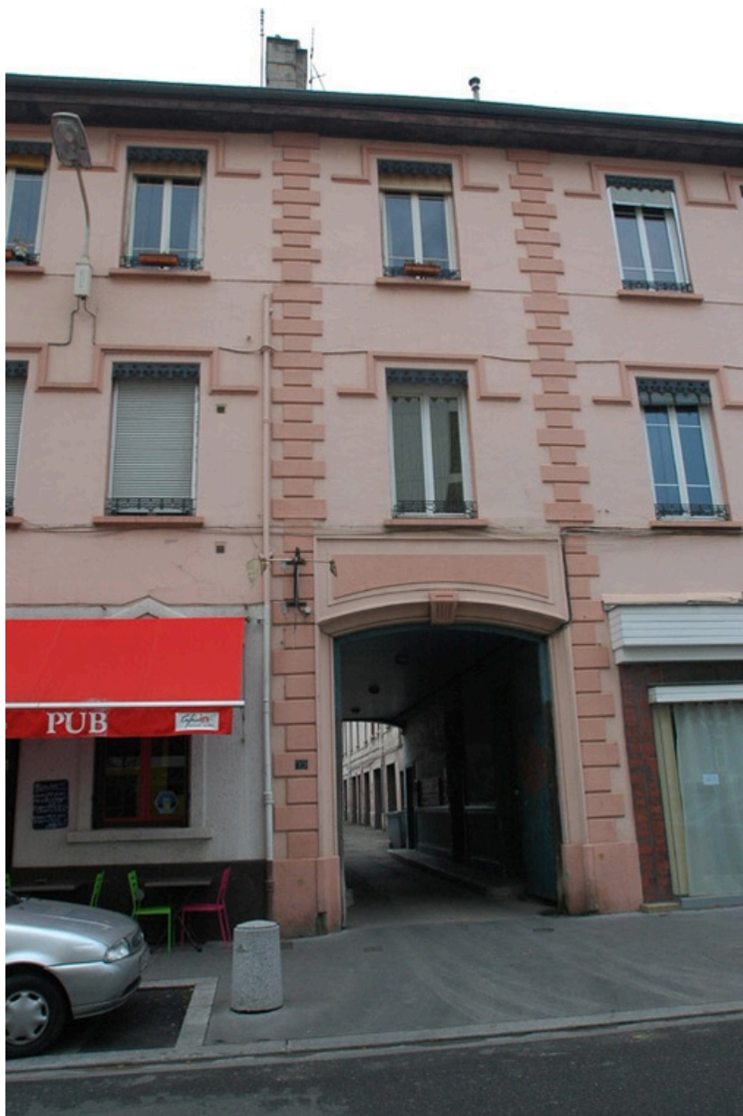
Porche d'entrée, façade principale rue Etienne Richerand.
