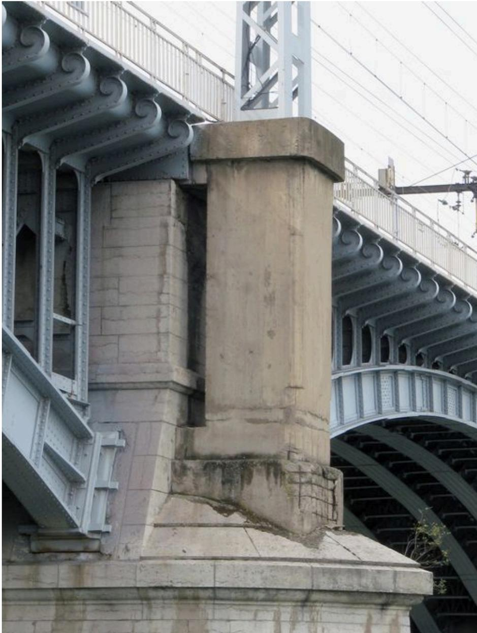
Pile, face amont, vue de détail : ancrage de l'arche et du support de mât (depuis la rive gauche)
