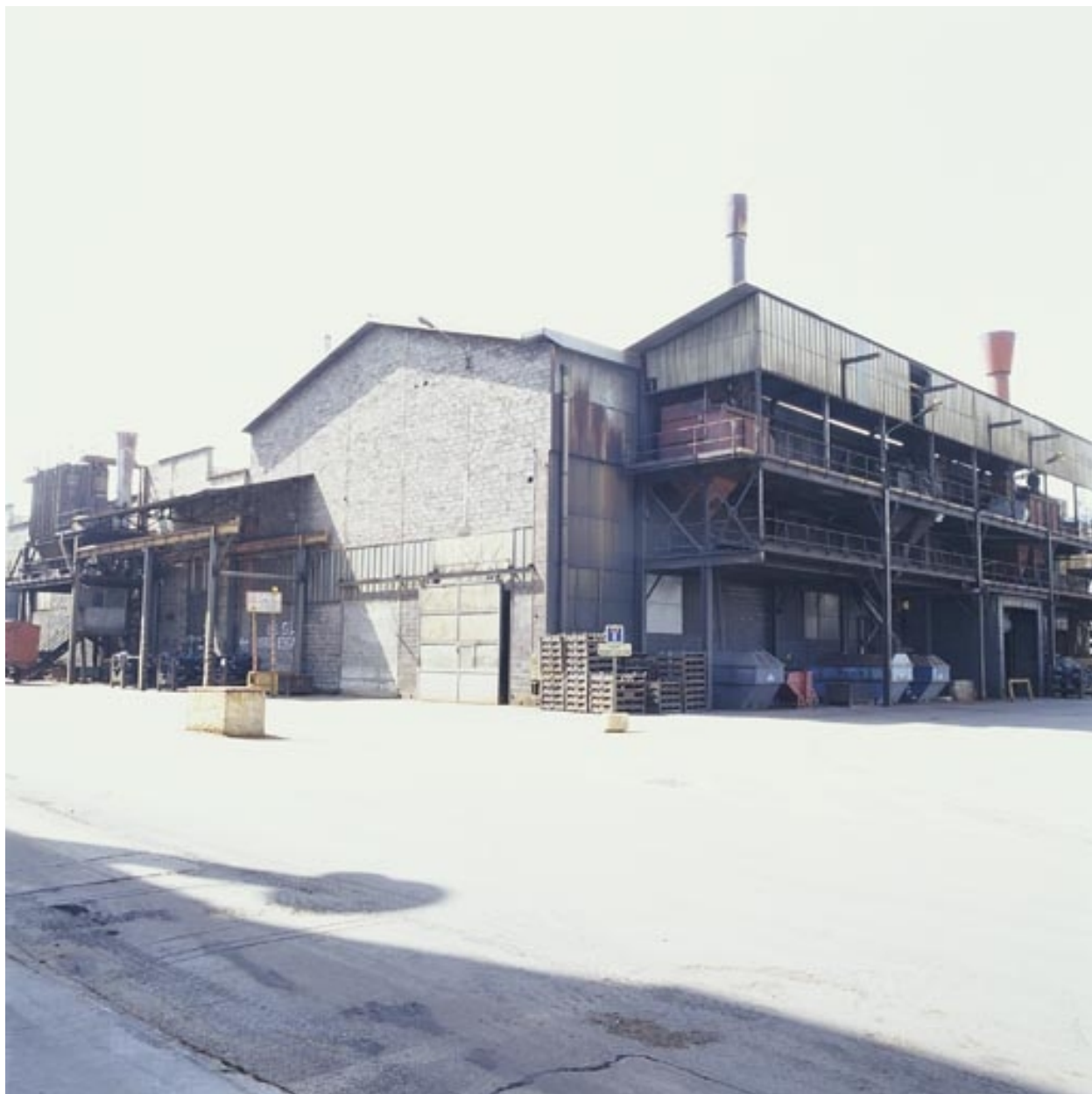
Fonderie, vue est, parachèvement sud, ligne ébardage.
