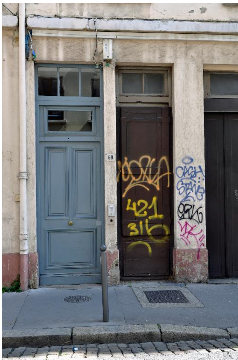
Elévation sur rue, portes jumelées
