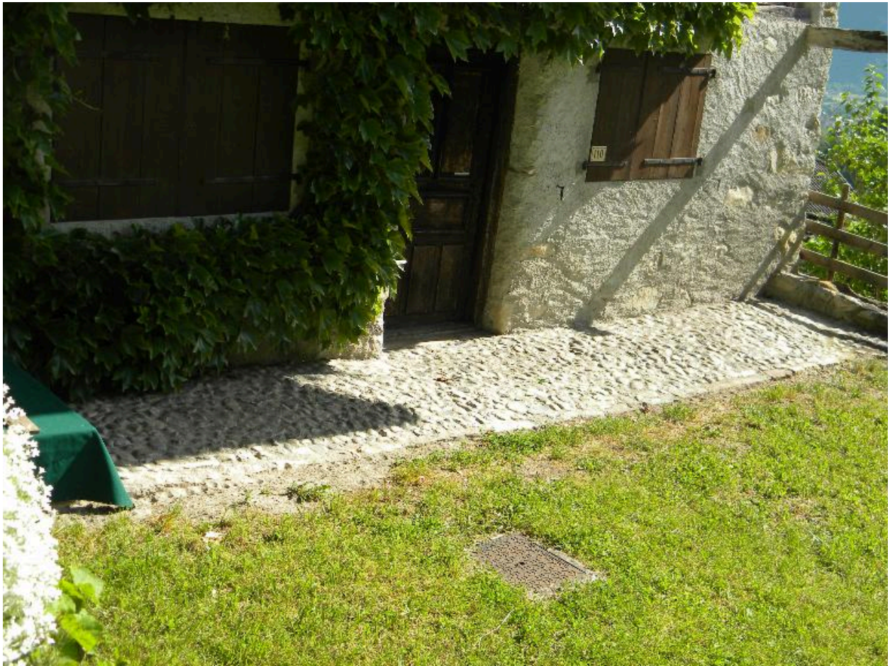
Détail de la calade située en façade de la maison.
