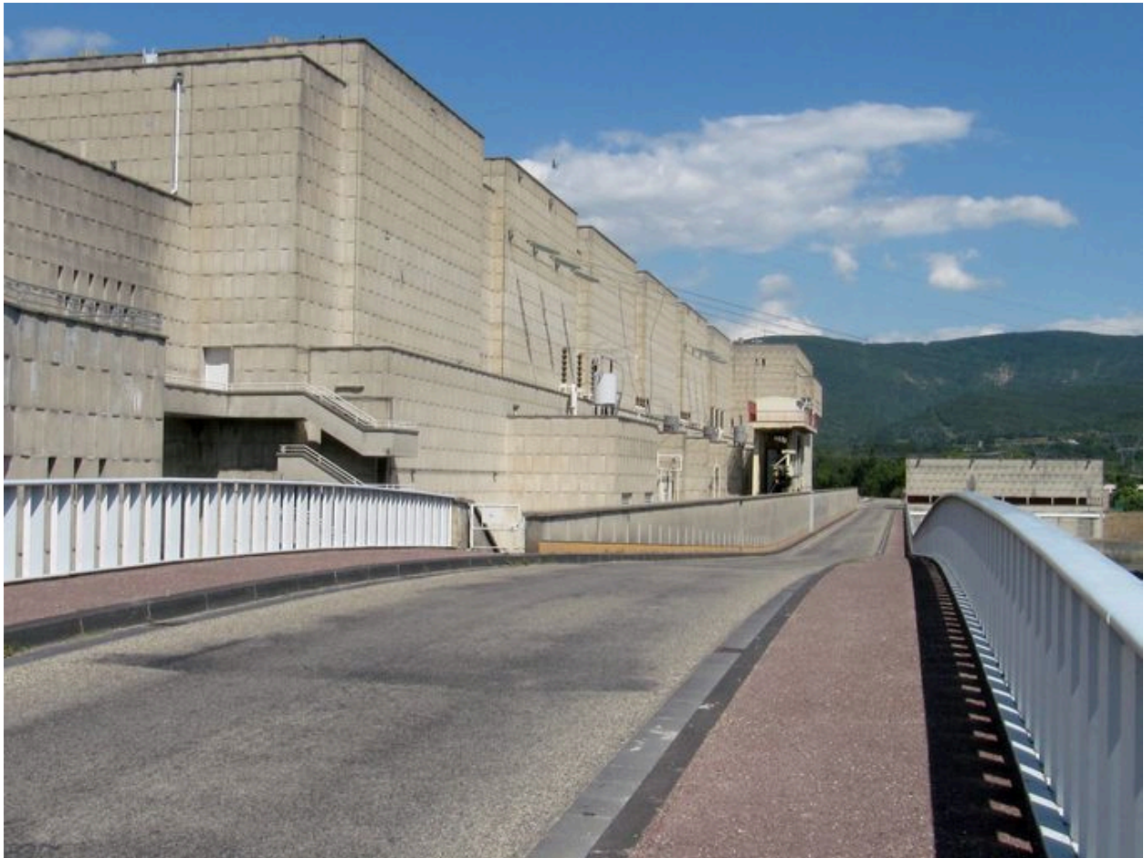
Chaussée du pont routier (depuis la rive droite)
