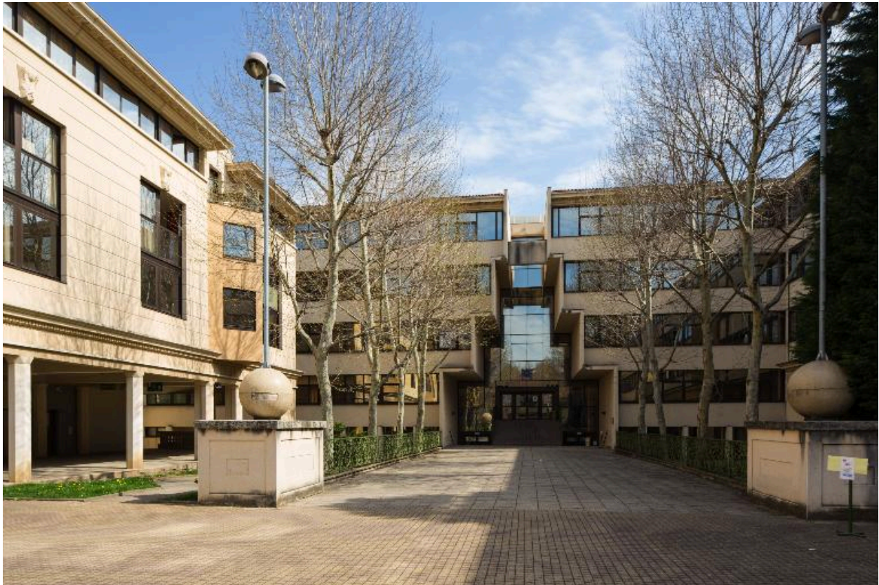
Vue de la façade principale du bâtiment C
