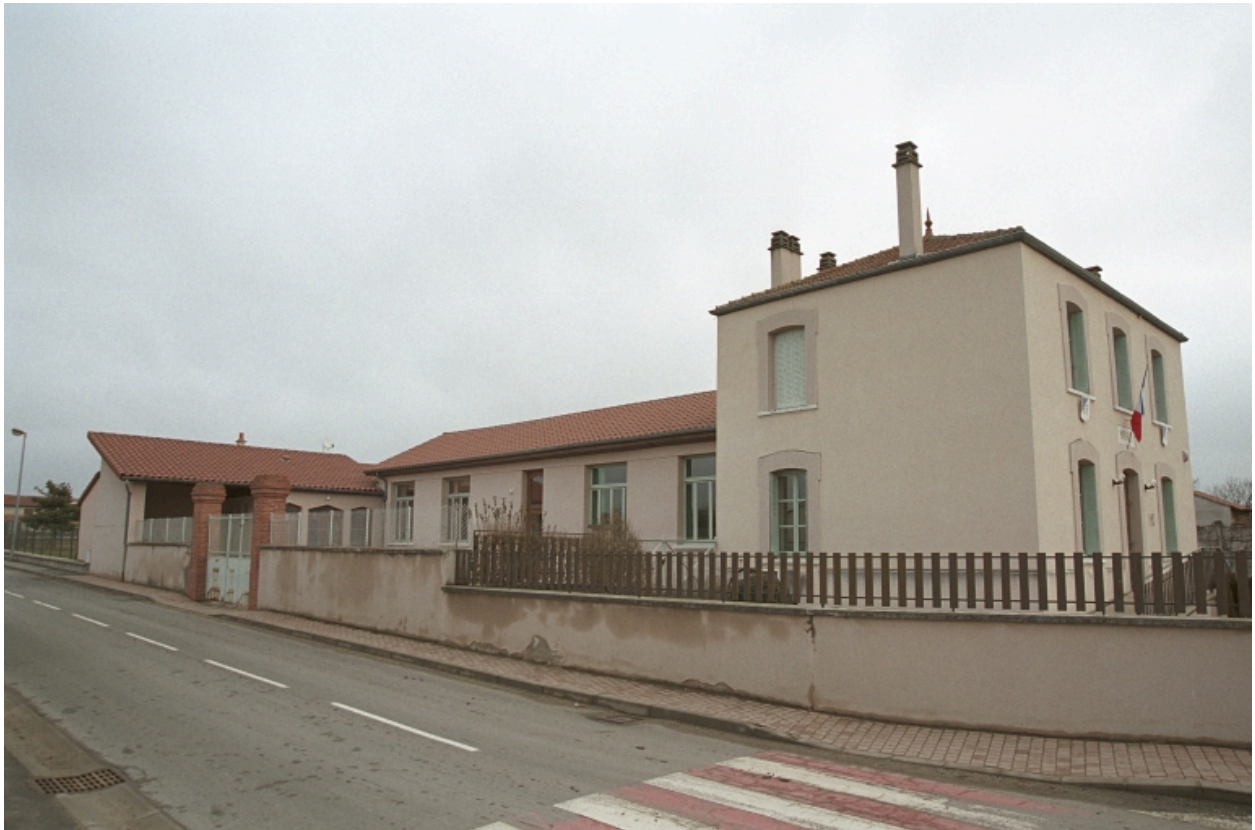
Vue d'ensemble de trois-quarts de la mairie-école, au bourg (1985 B2 940, 941).
