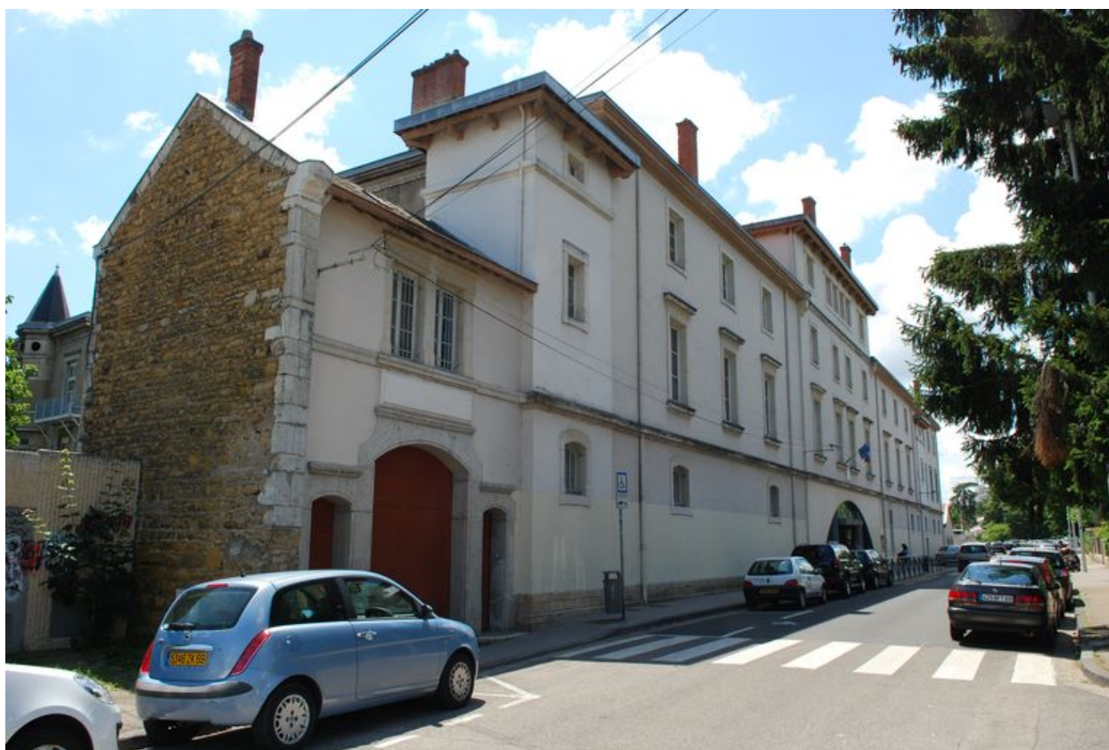
Elévation sur rue, depuis le nord-est
