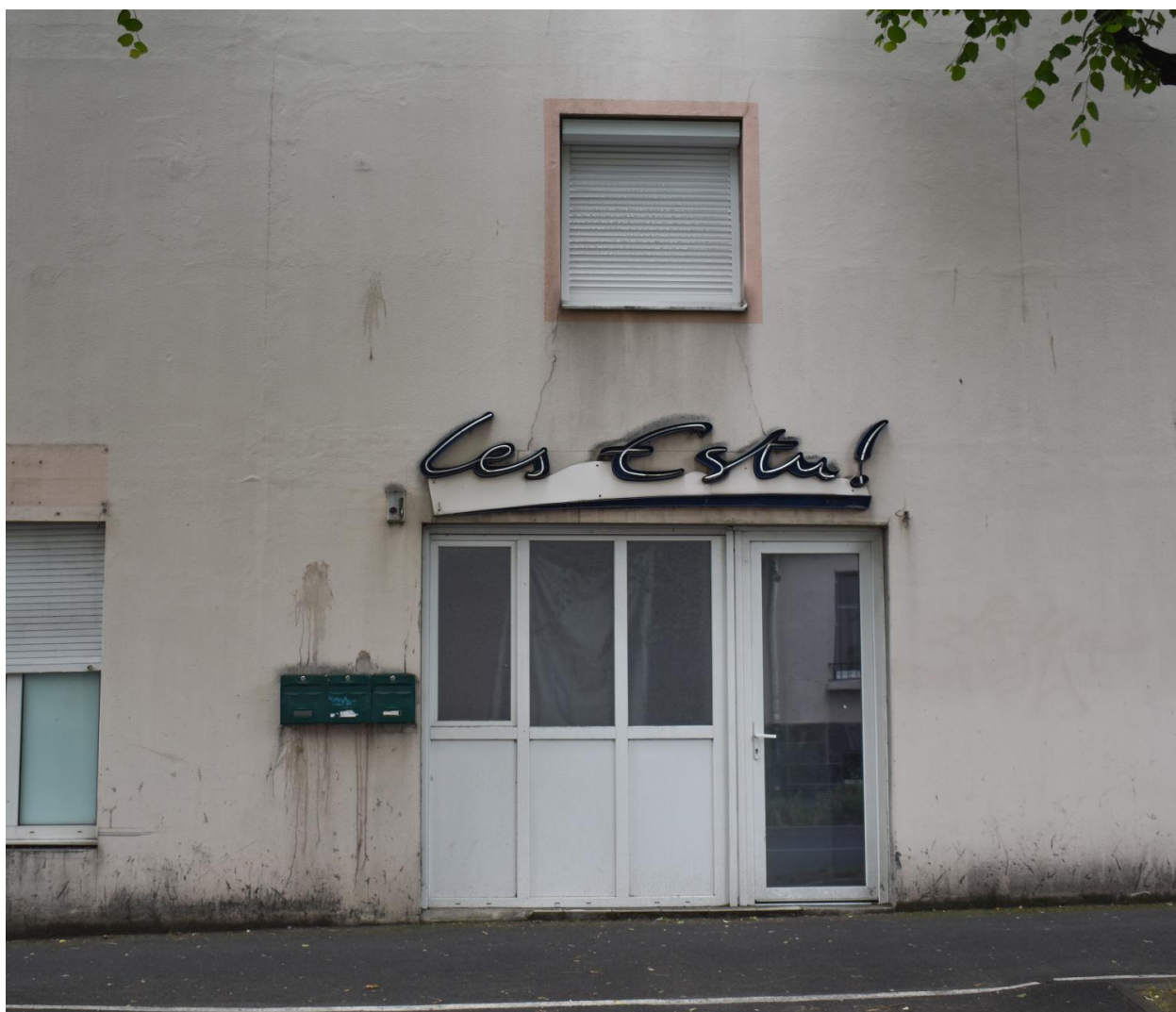
Porte d'entrée sur le boulevard
