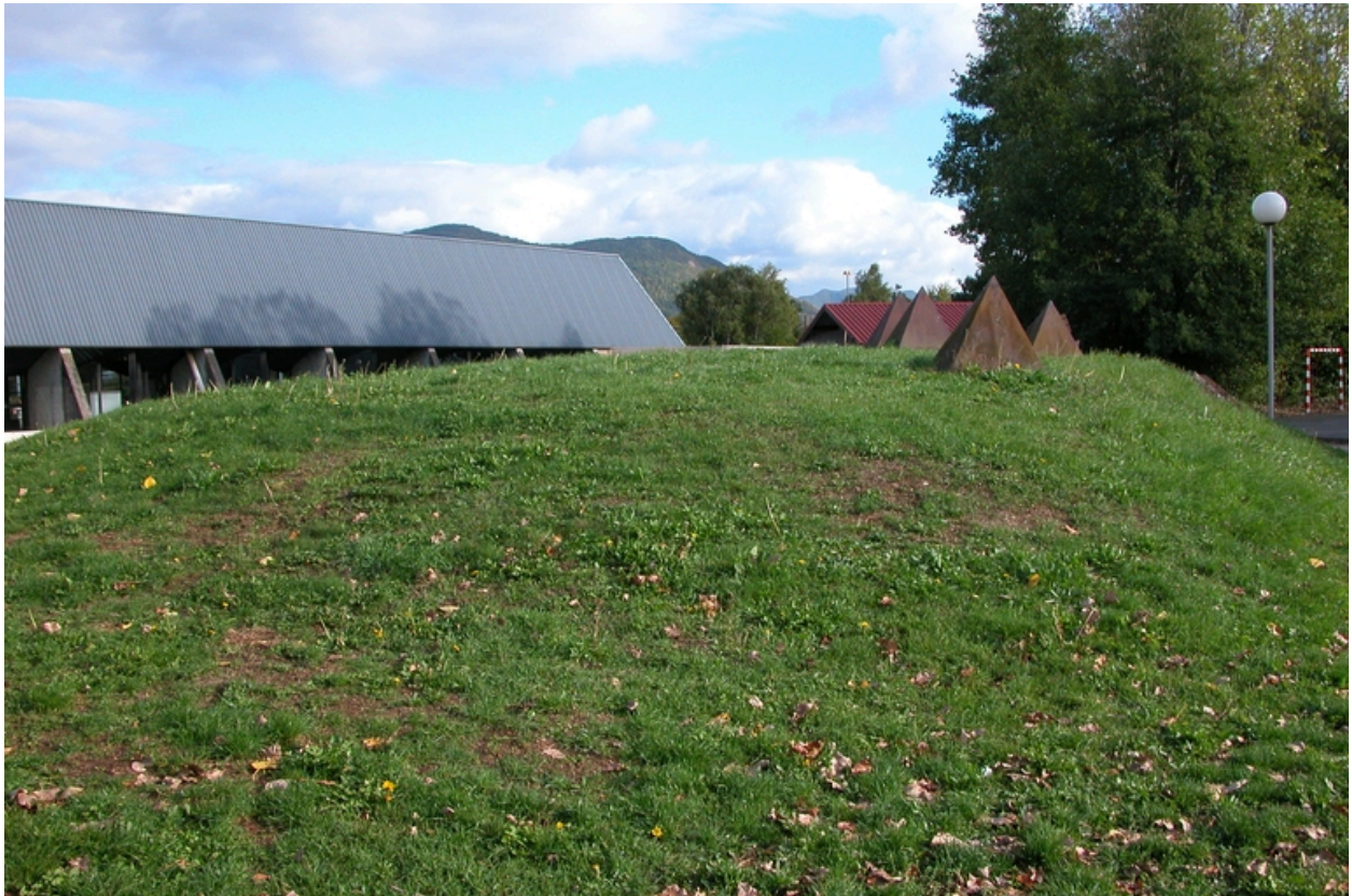
Vue générale depuis l'arrière du terre. Au fond, la toiture du gymnase.
