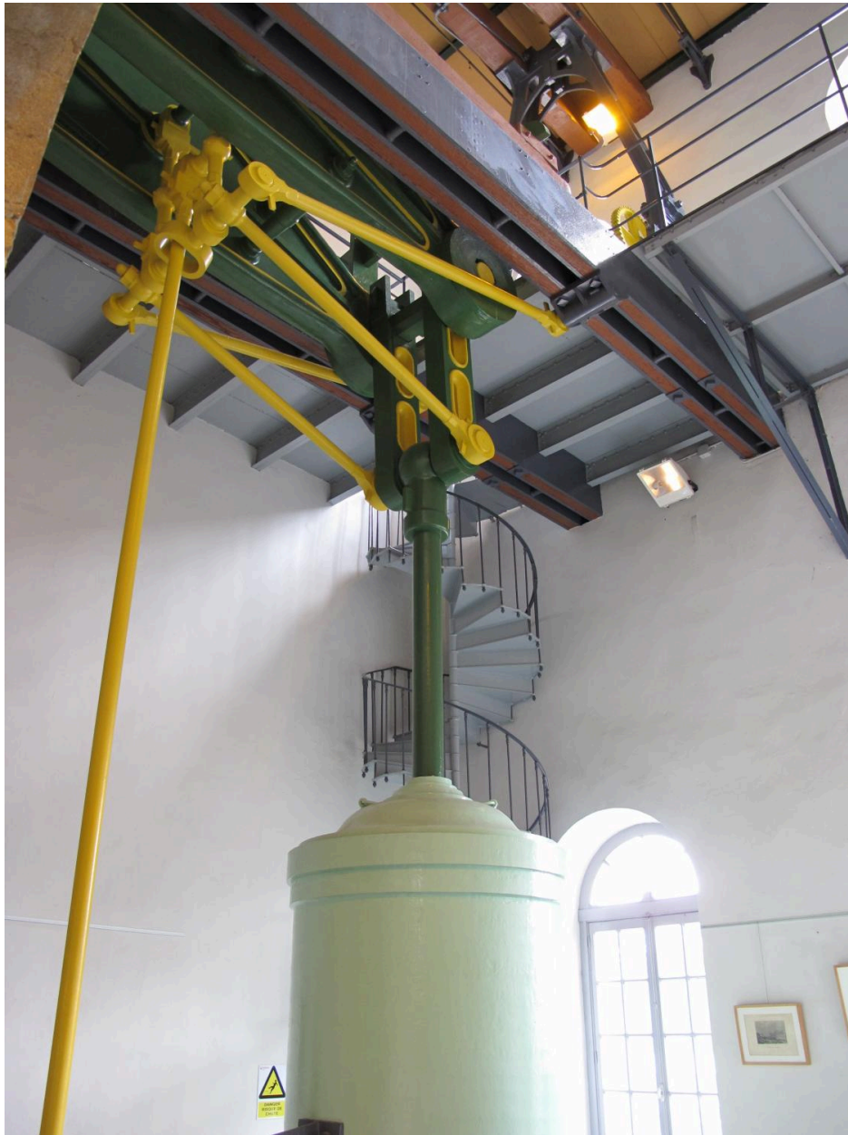
Détail partie haute
