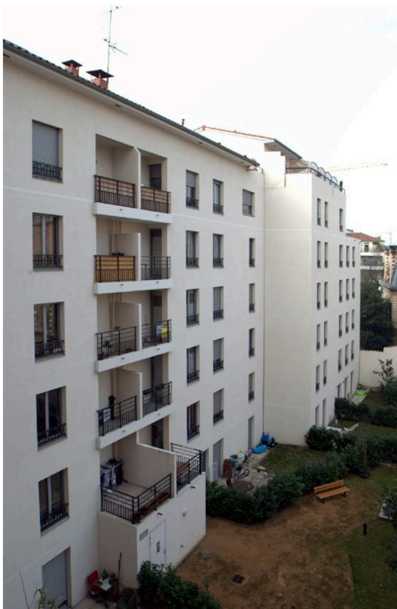
Elévation postérieure, vue partielle (15 rue Jules-Brunard)
