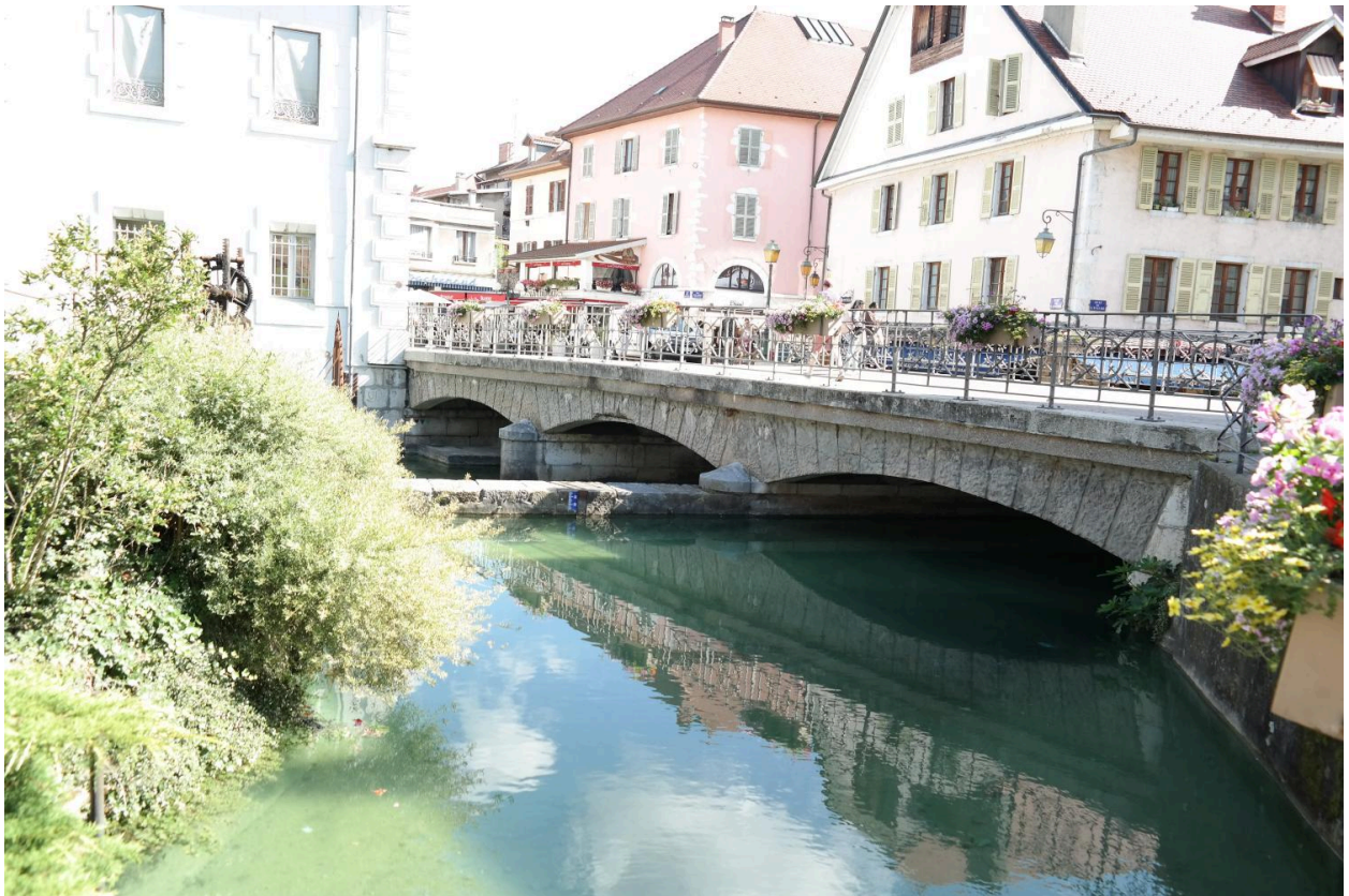
Pont de la République, vue de la face amont
