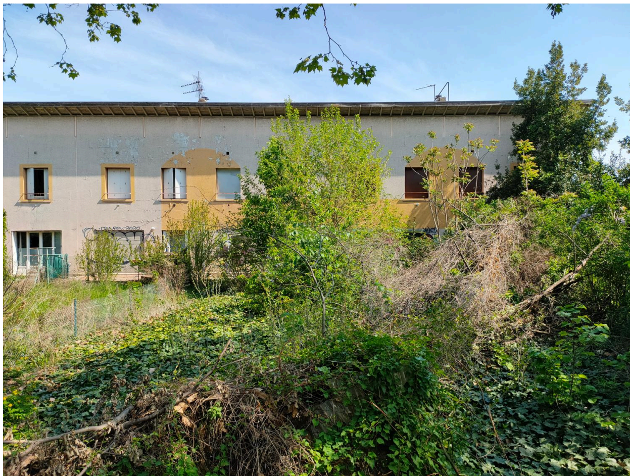
Cité ouvrière P.L.M. dite Coblod - vue depuis le boulevard du Dr Coblod
