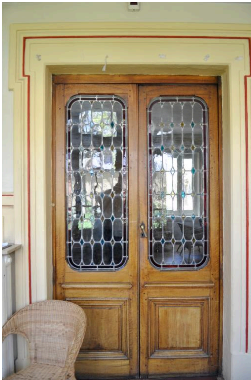
Aile sud, détail d'une porte intérieure, verrière à cabochoons colorés
