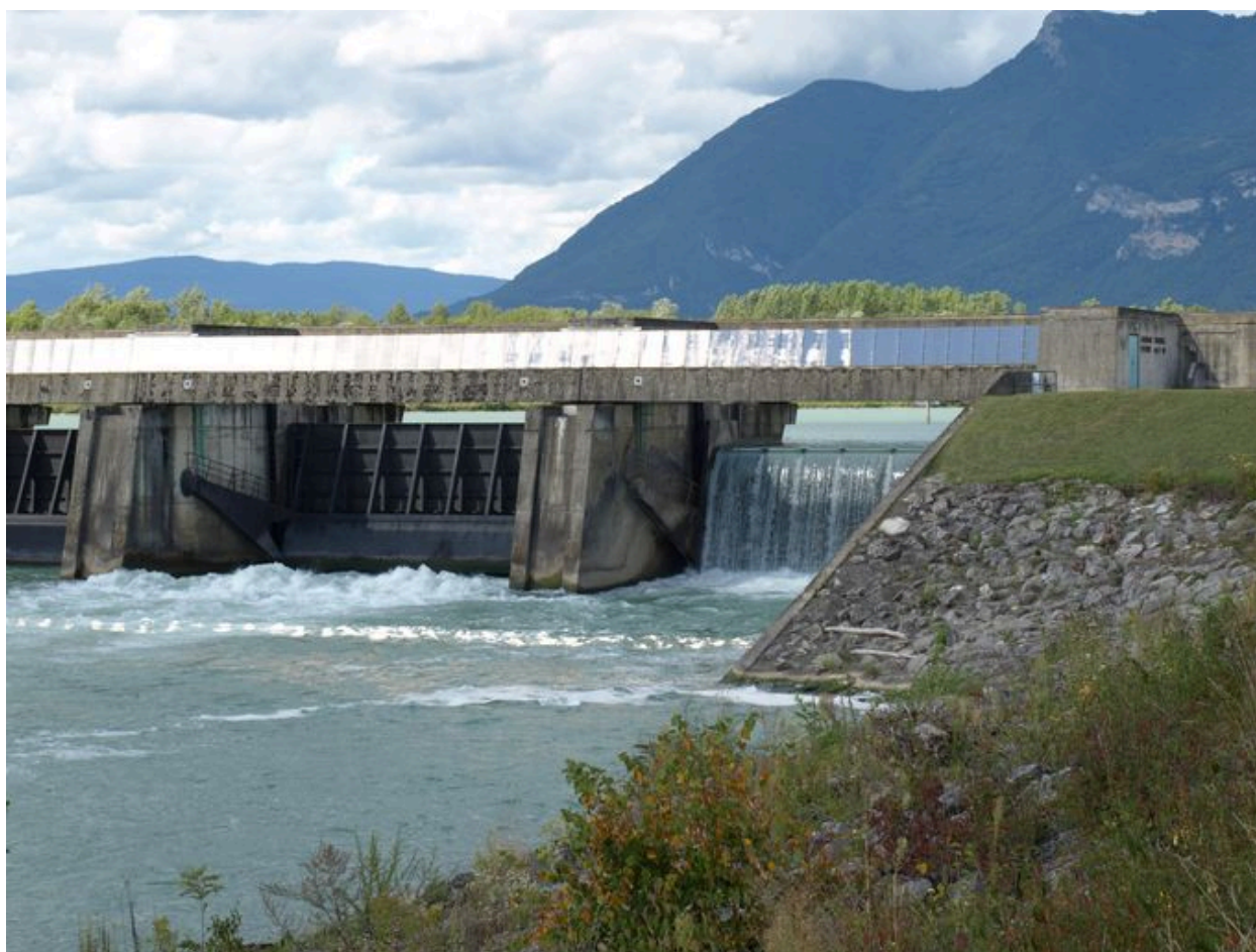
Vue partielle, passes : face aval (depuis la rive gauche)
