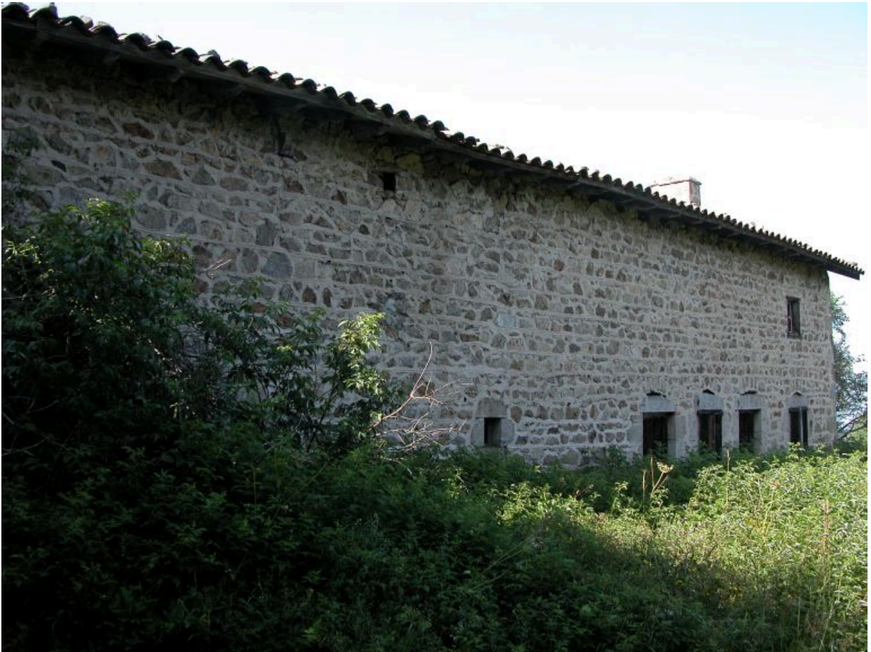
Vue d'ensemble du mur gouttereau sud-est.
