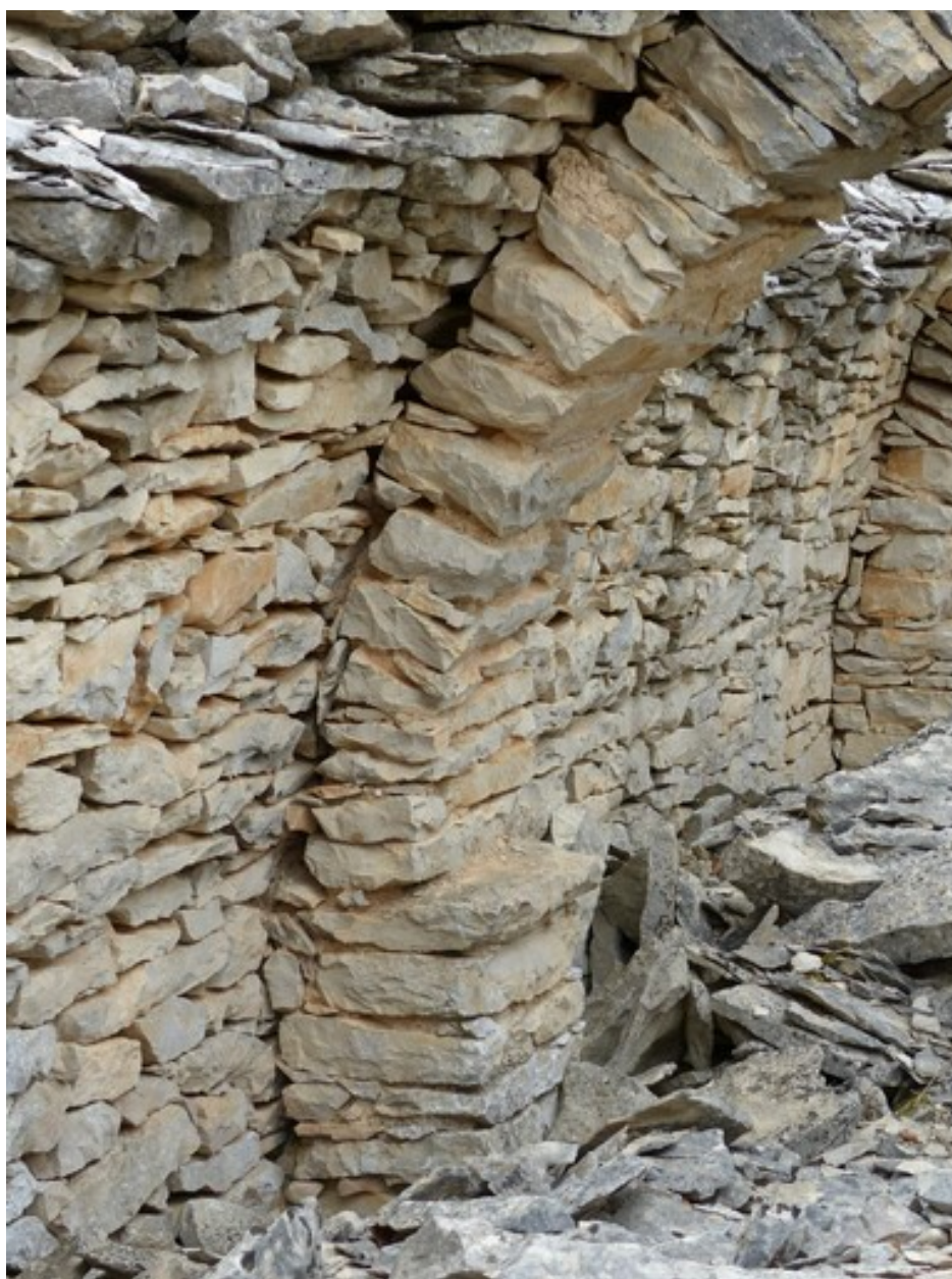
Mur ouest, départ de la voûte et de l'arc diaphragme central.
