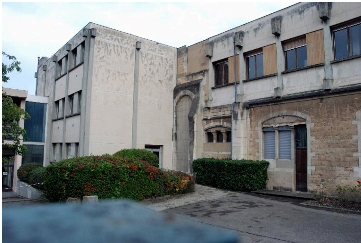
Infirmierie et bâtiment scientifique, depuis l'ouest (élévation antérieure, rue des Farges)
