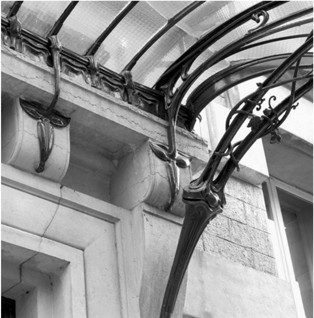
Elévation nord : détail de la partie droite de la marquise
