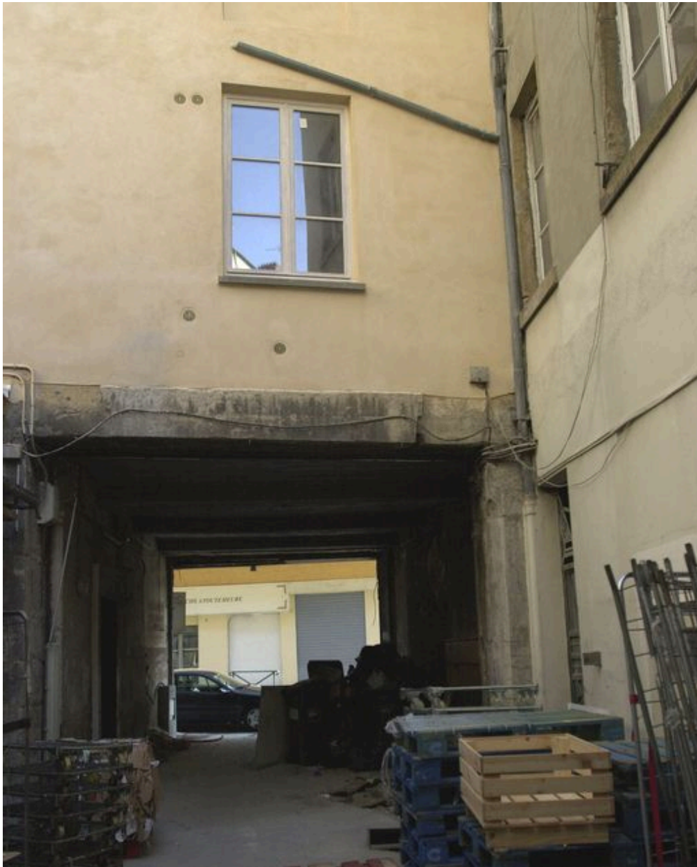
Vue du passage couvert depuis la cour
