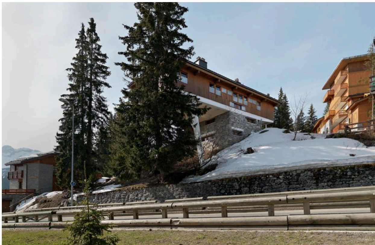
Vue depuis le nord-est
