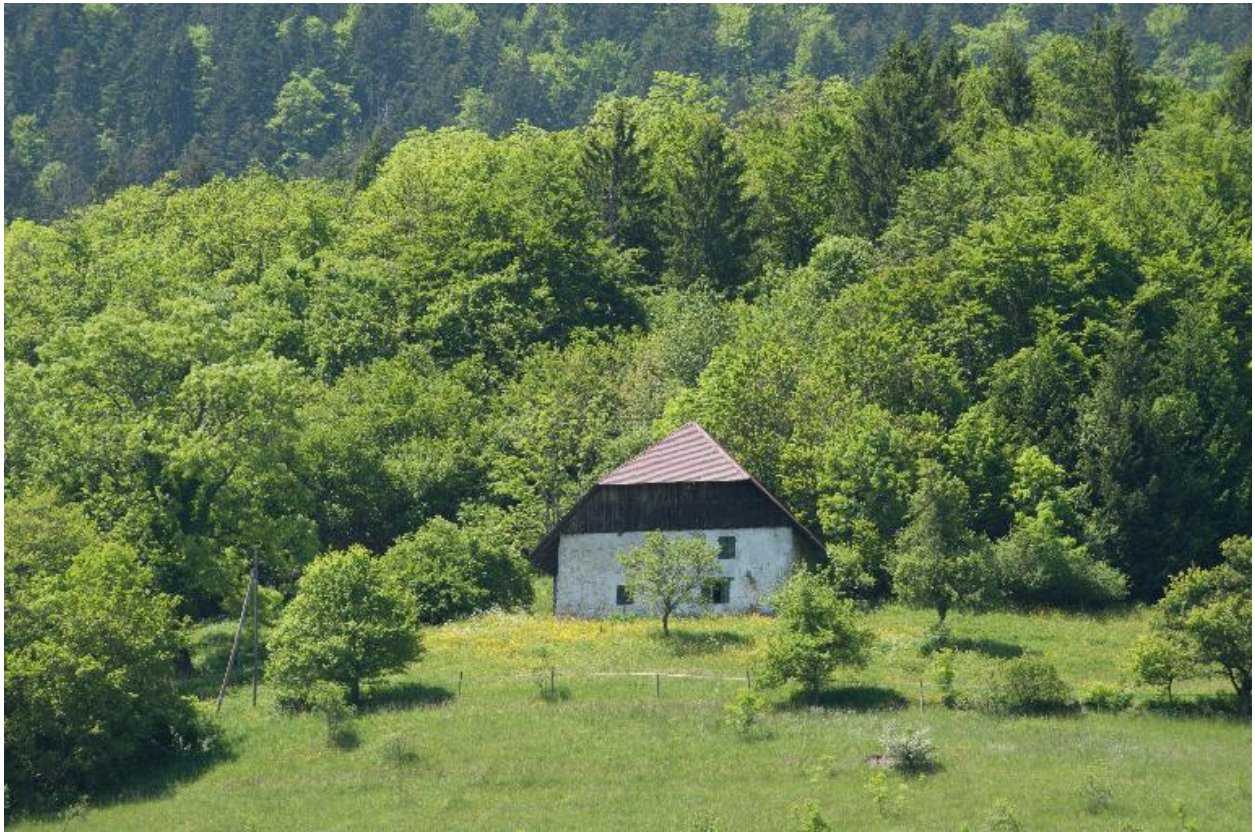
Vue d'ensemble de la ferme dans son environnement
