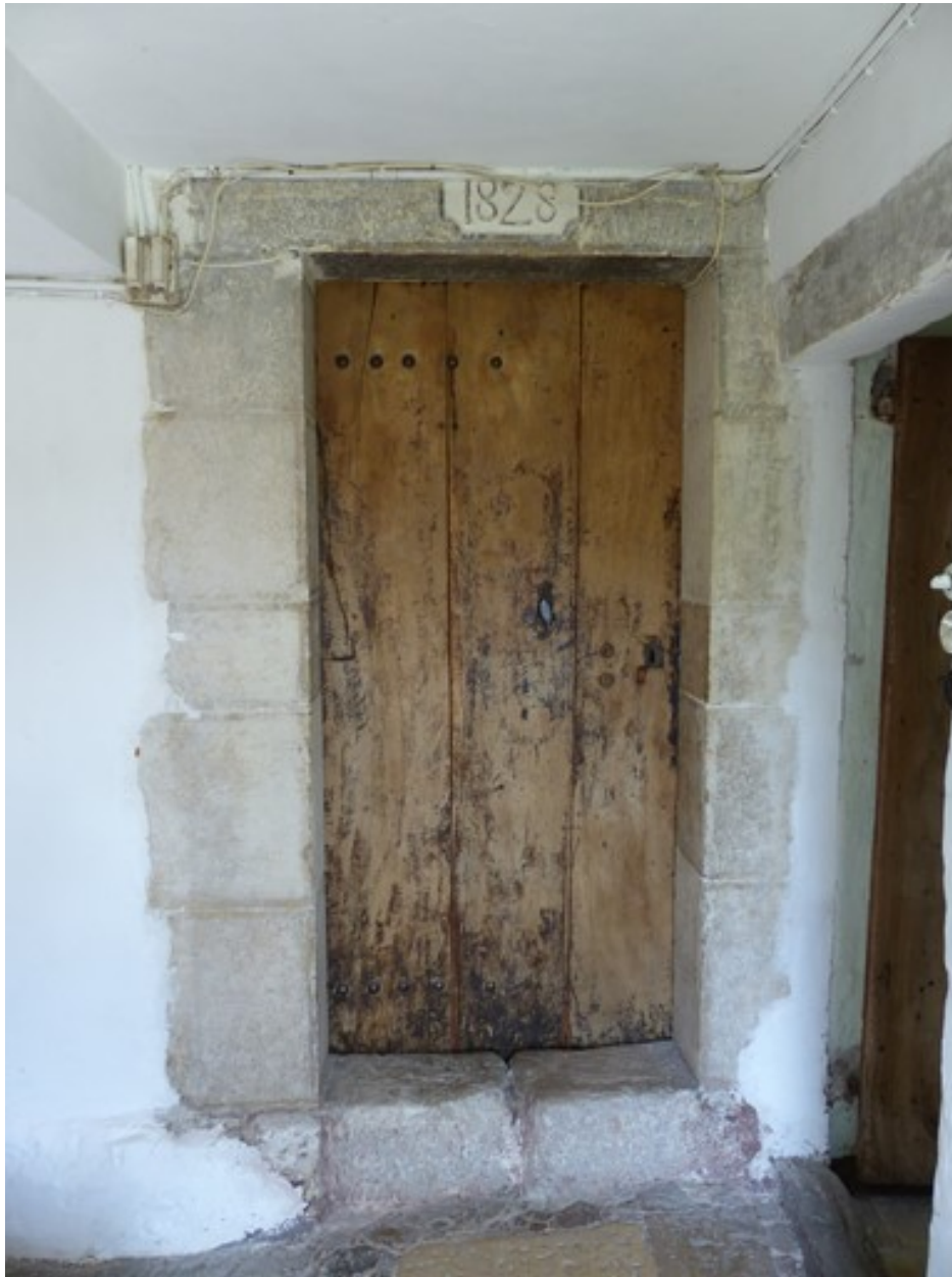
Bâtiment principal. Troisième étage de soubassement, vestibule. Mur est, porte du logis.
