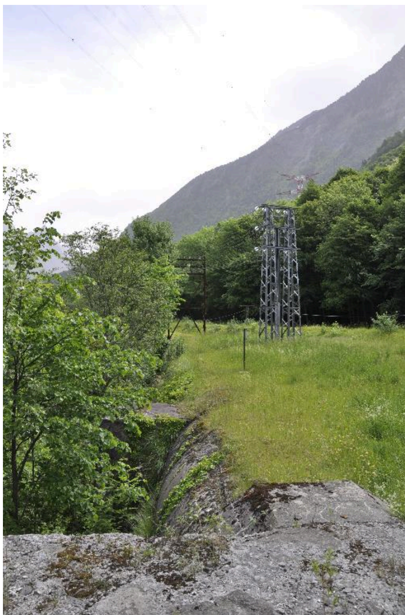
Vue des pylones et des lignes à haute tension
