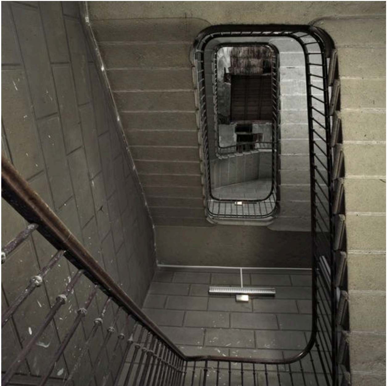
Cage de l'escalier ouest, vue d'ensemble
