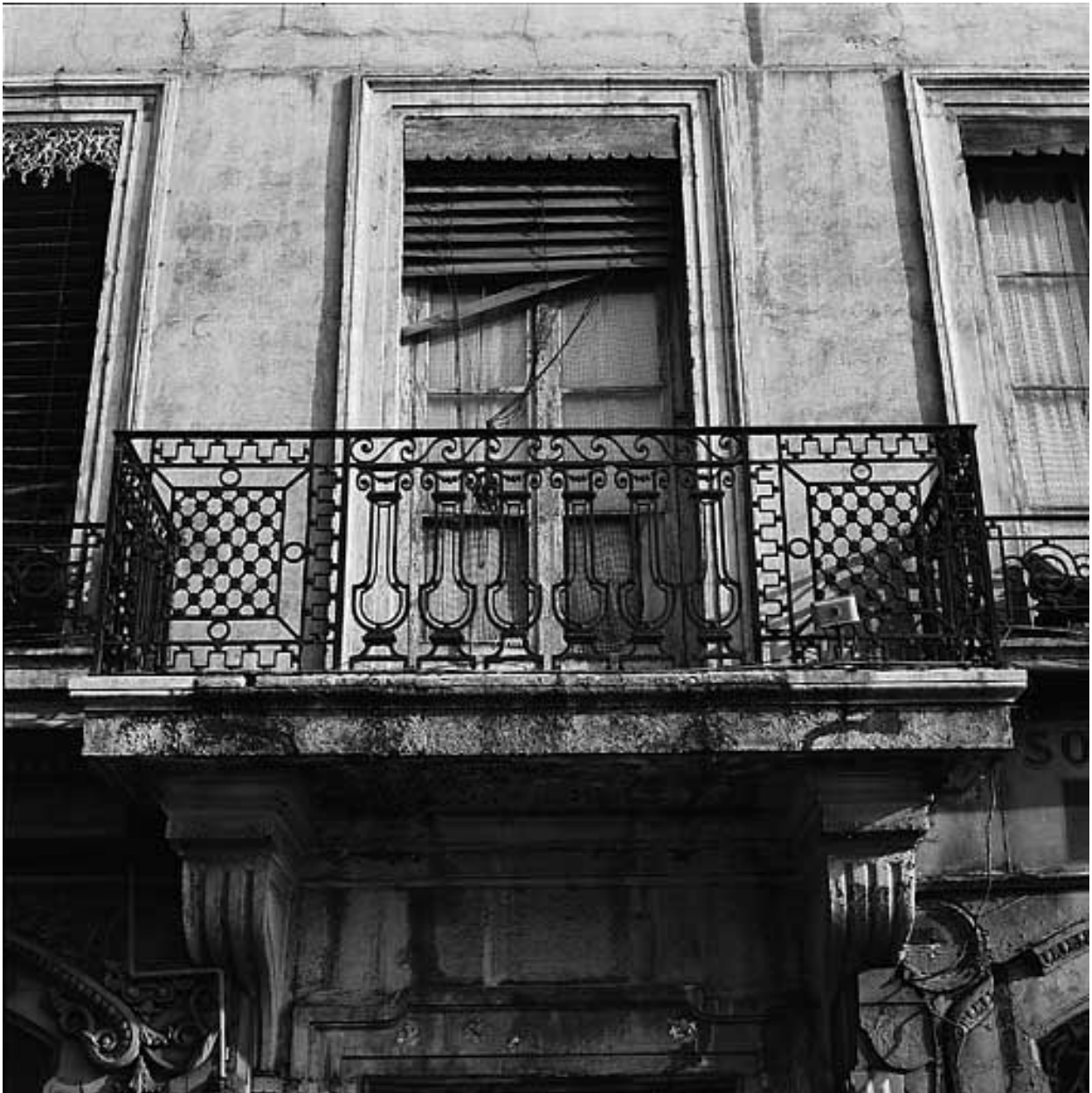
Façade principale, balcon et baie centrale du 1er étage
