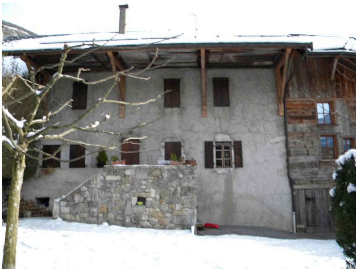
Façade principale de la partie habitation avec escalier extérieur.
