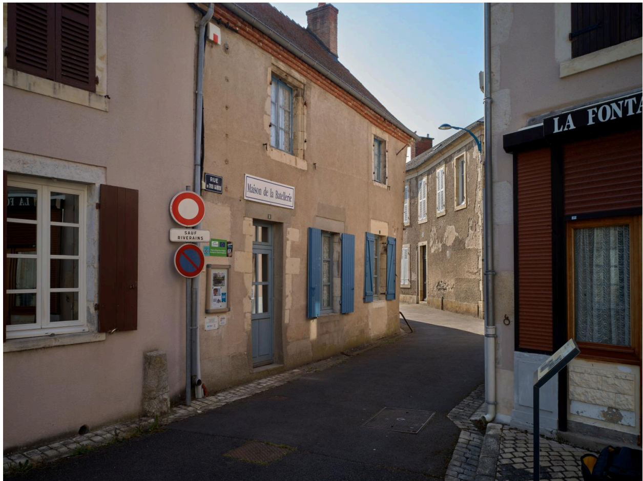
Vue de la façade sur la rue du Trou-Gandou.
