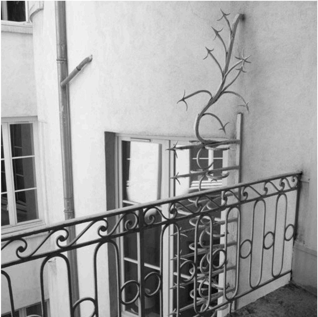
Escalier du premier corps, repos du 3e étage d'escalier, garde-corps et artichaut
