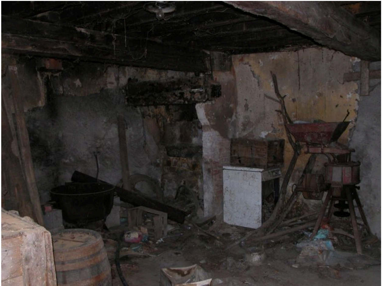
Vue partielle intérieure de la cuisine du logis. Détail de la cheminée et de l'emplacement de l'ancien four à pain.
