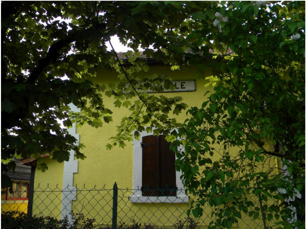
Détail d'un encadrement.
