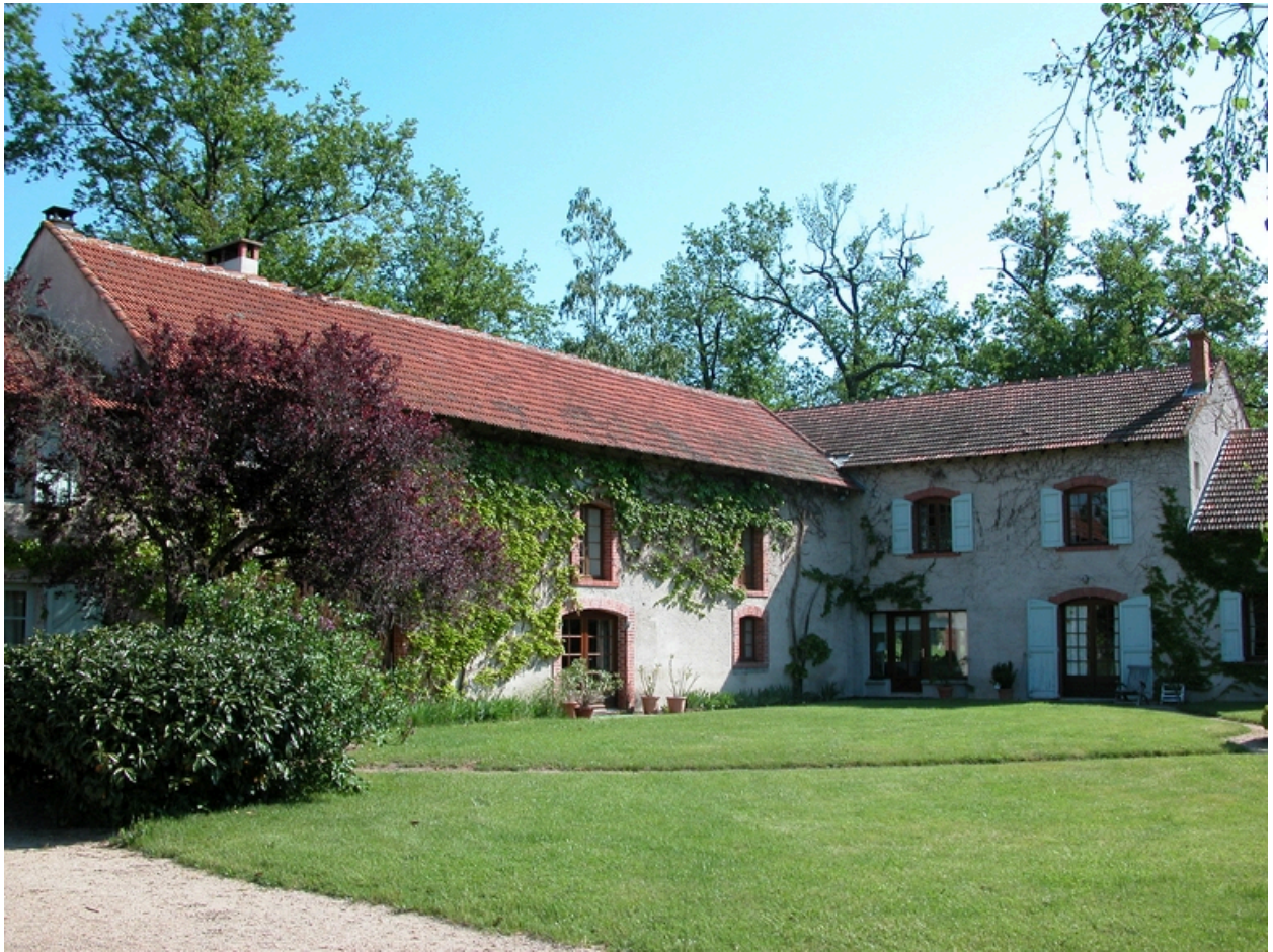
Vue du logis et de la grange-étable.
