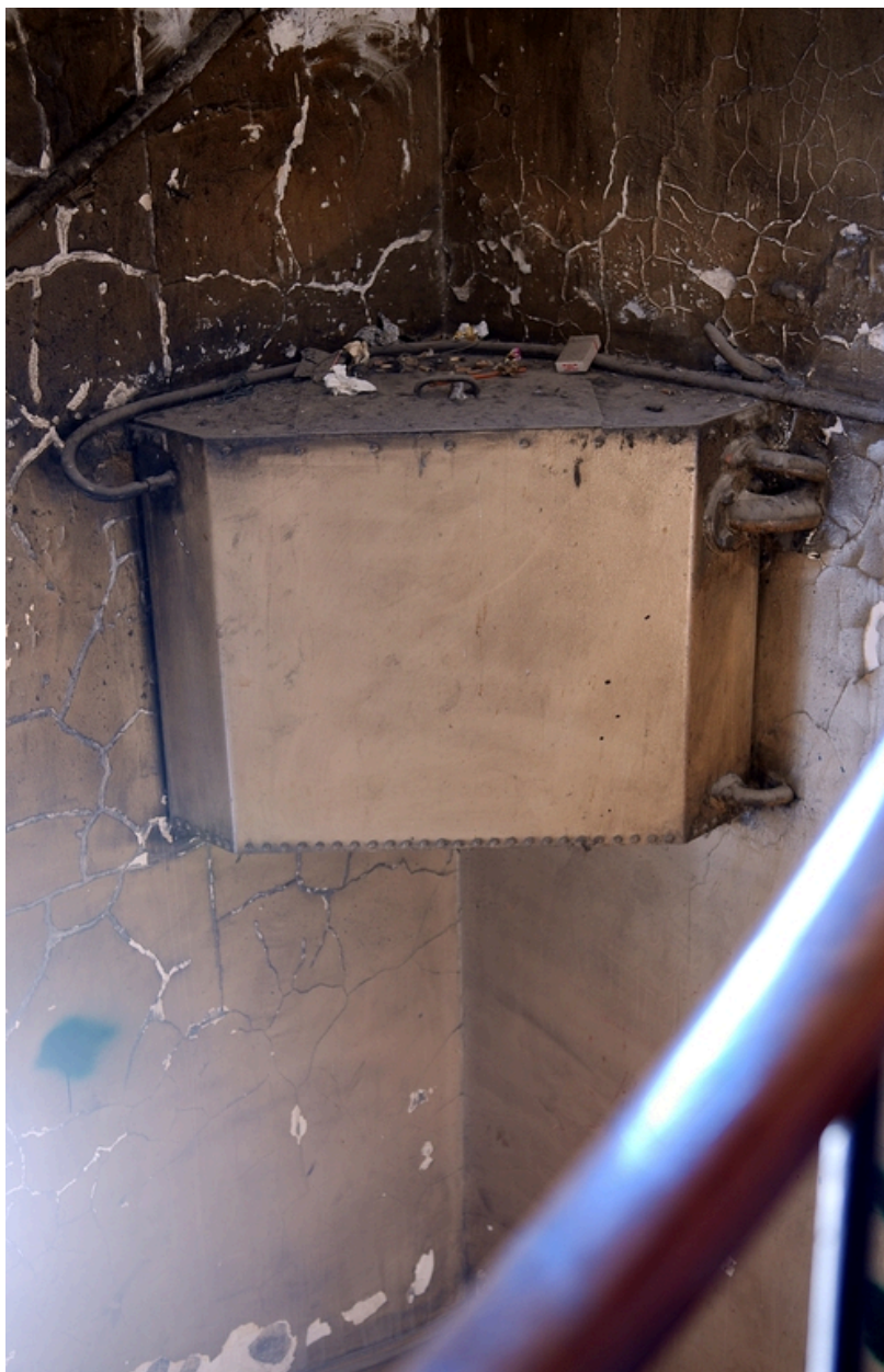
Corps de bâtiment sud : réservoir d'eau dans la cage d'escalier
